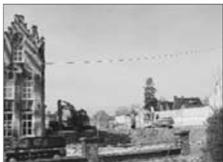
De afbraakwerken op de Bekaertsite zijn al in een vergevorderd stadium.
